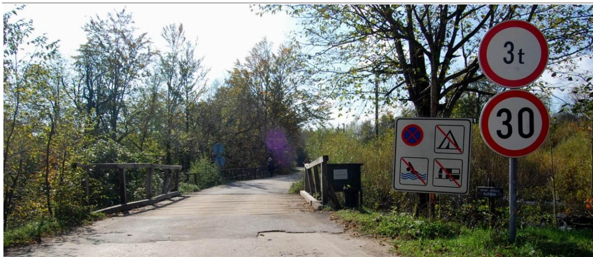
Slika 4.1-1. Znakovi upozorenja i zabrane na prilazu na most sa strane mjesta Poljanak.
