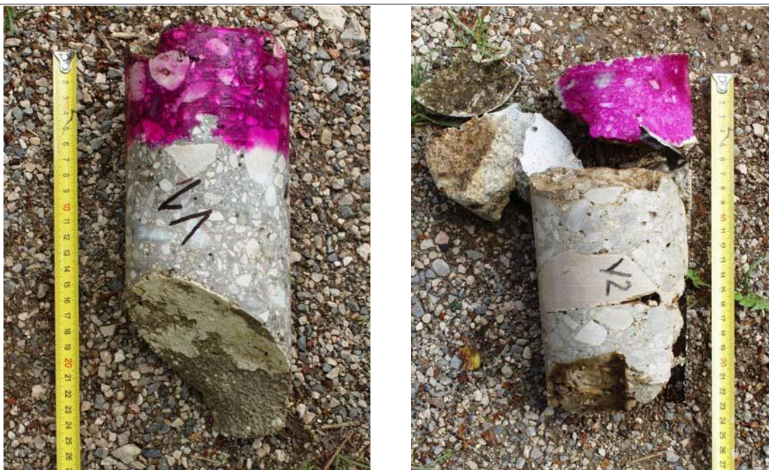
Slika 2.3-4. Prikaz izbušenih betonskih uzorka V1 (lijeva slika) i V2 (desna desna slika) iz upornjaka. Fotografije su preuzete iz Izvedbene tehničke dokumentacije.
